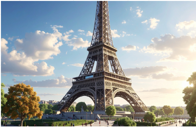
Figura 2. La Torre Eiffel, mostrando la estructura de triángulos que le da estabilidad y resistencia.
