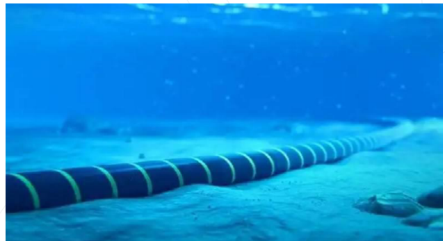
Figura 1. Cables submarinos de fibra óptica que conectan continentes. Nota: Tomado de zms Cable, 2023.
