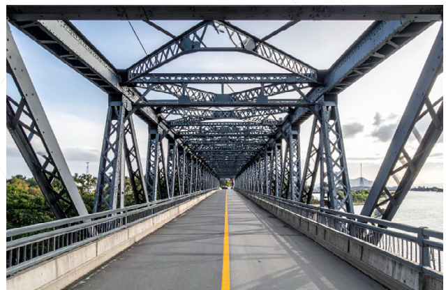
Figura 1. Ejemplo de una estructura de celosía. Fuente: elaboración propia por medio del software de AI generativa Adobe Firefly.
